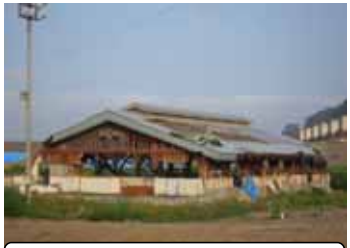
被害を受けた小本中の屋内プール
