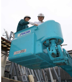
電気工事作業
